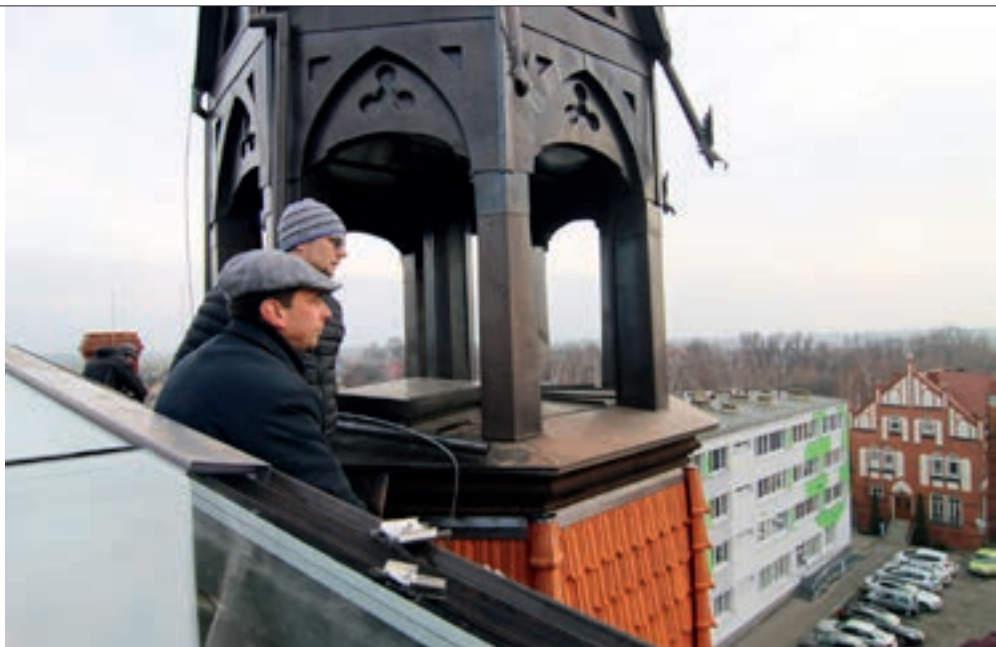
Zakończył się trwający od sierpnia remont dachu dworca
