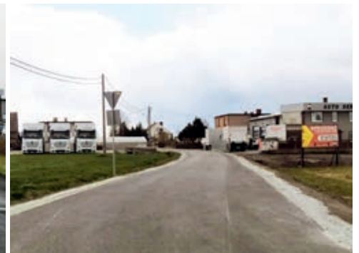
Ulica Wierzbowa przed i po remoncie
