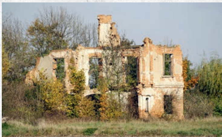
Głóski - pozostałości pałacu sprzed rozbiórki
