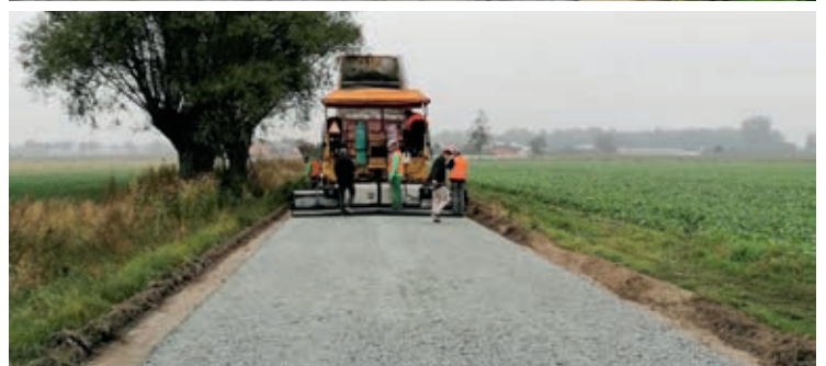
Ul. Polna w Kotowiecku w trakcie remontu
