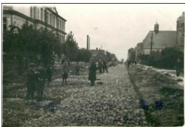
[3] Idąc dalej w kierunku stacji kolejowej
