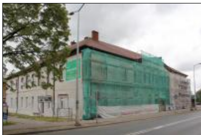
[2]Renowacja rozpoczęła się od osuszania ścian
