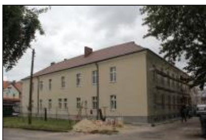
[3]Budynek czeka również remont kamiennych schodów
