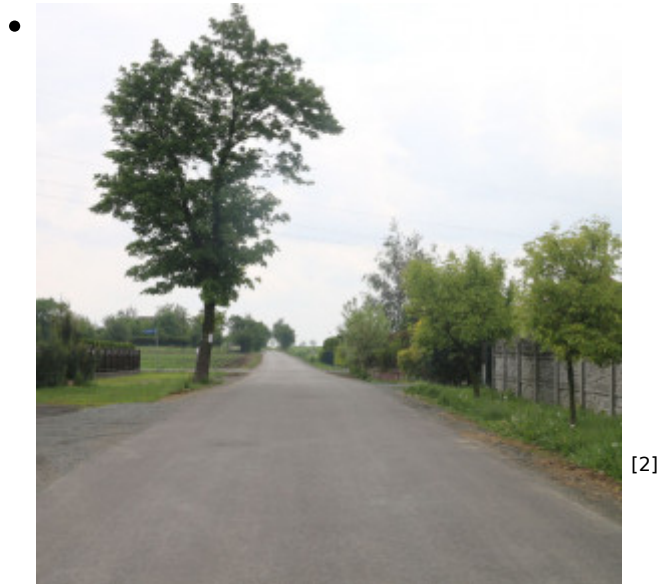
ul. Klonowa po remoncie
