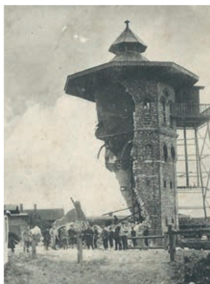
Rok 1914, zniszczona wieża ciśnienia w Kaliszu
