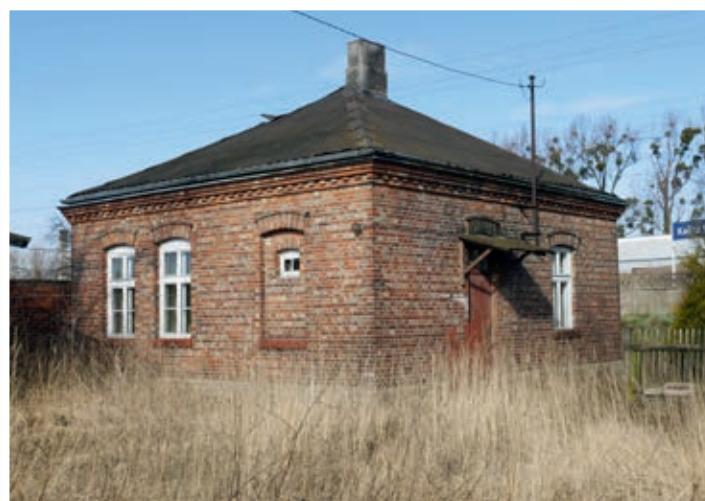
Budynek maszynisty stacji pomp w Szczupiornie
