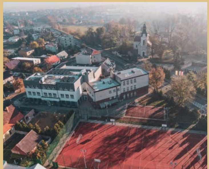
Przebudowa, rozbudowa i nadbudowa Szkoły Podstawowej w Skalmierzycach
