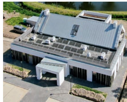
Budynek świetlicy jest energooszczędny za sprawą zamontowanej na dachu fotowoltaiki
