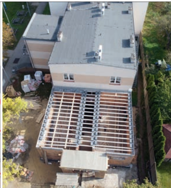
W nowym pawilonie zmieszczą się dwie szatnie wraz z prysznicami i toaletami
