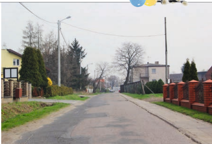
Ul. Dąbkowa otrzyma nową nawierzchnię, chodniki i kanalizację deszczową
