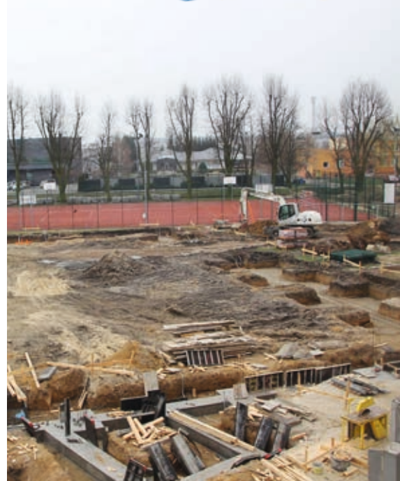
Budowa hali sportowej to jedna z ważniejszych tegorocznych inwestycji
