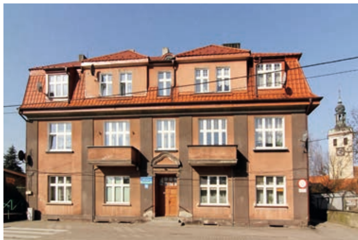
Kamienica przy ul. Kardynała Stefana Wyszyńskiego przed i po remoncie
