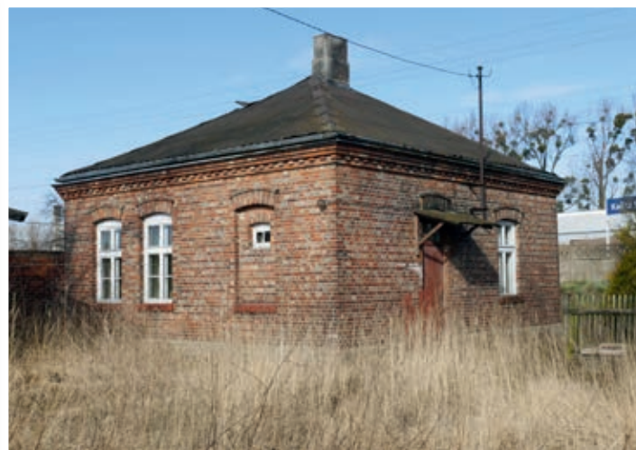
Budynek maszynisty stacji pomp w Szczupiornie
