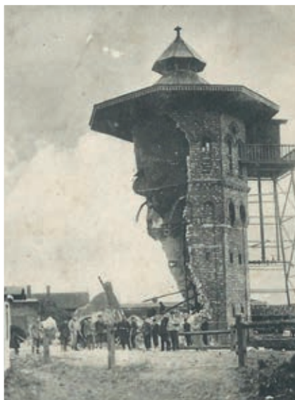
Rok 1914, zniszczona wieża ciśnienia w Kaliszu
