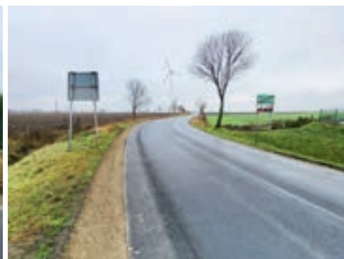
Zmodernizowany odcinek drogi w Biskupicach ma 1 km
