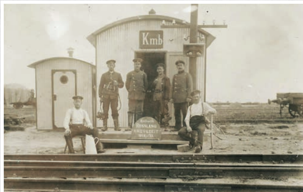
Posterunek kolejowy na linii Kalisz - Skalmierzyce
