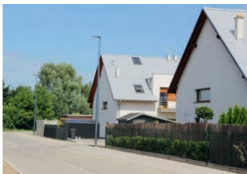
... i po remoncie
