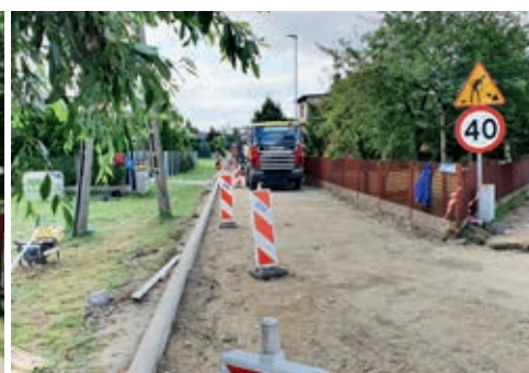
... i w trakcie remontu
