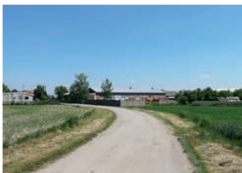
Leziona przed remontem...
