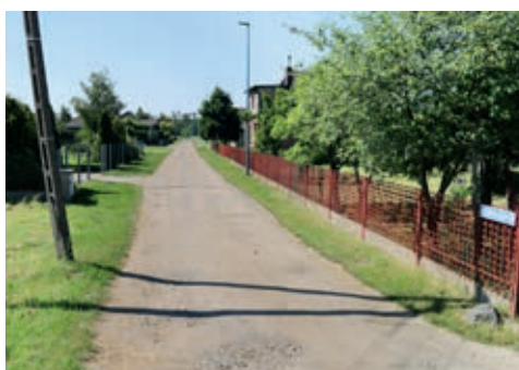
Skalmierzyce, ul. Słoneczna przed remontem...
