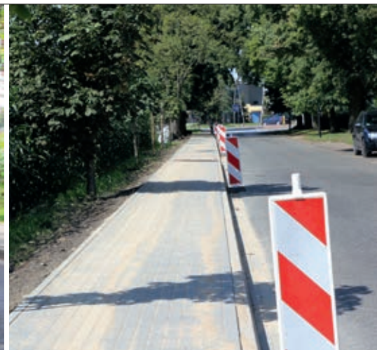
Przebudowa ul. Podkockiej w Skalmierzycach
