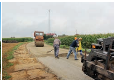
... i w trakcie remontu
