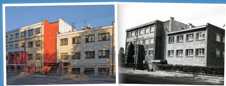
Urząd Gminy i Miasta po termomodernizacji w 2012 roku, obok Urząd Gminy i Miasta w 1990 roku.
