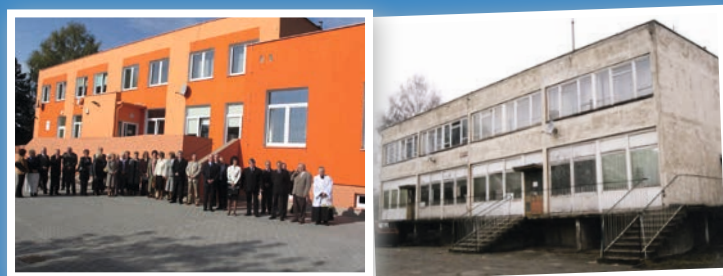
Ośrodek zdrowia po remoncie - oddanie do użytku w 2006 roku, obok ośrodek zdrowia przed remontem - lata 90-te.
