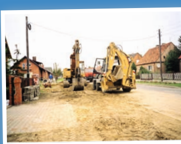
Kanalizacja sanitarna - rozpoczęcie budowy na terenie gminy w 1999 roku.
