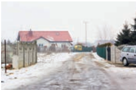
Ul. Boczna przed i po remoncie
