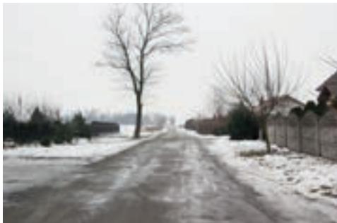
Ul. Klonowa przed i po remoncie
