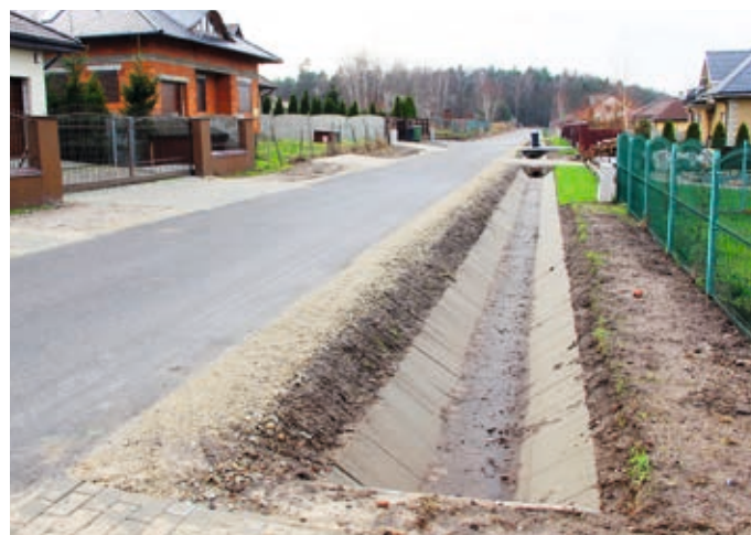
łączna długość zmodernizowanej drogi wynosi ponad 1,4 kilometra
